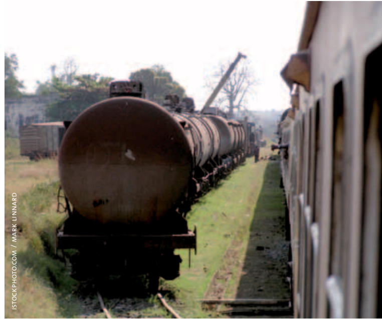
Verotulot ovat vakaampi rahoituslähde toimivan infrastruktuurin rakentamiseen ja peruspalveluiden järjestämiseen kuin lainat ja ulkomainen apu. Kuvassa rapistuvaa rautatiekalustoa Tansaniassa.
